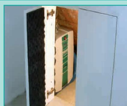
Kompakte Maße, welche die Installation auf einer kleinen Oberfläche in jeder Wohnung ermöglichen. Dabei besitzt das Gerät eine hohe Saugkraft und einen großen Staubauffangbehälter (11 Liter).
